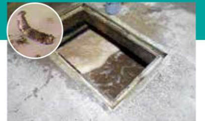
E 曝気槽(活性汚泥処理)
