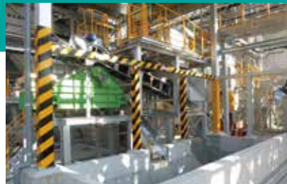
灰ビット 焼却灰はコンベアに集められ、路盤材等へのリサイクル利用、または最終処理場へ搬出されます。
