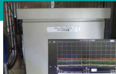
分析計 排ガスに含まれるCO・SOx・HCL濃度を24時間連続測定を行い、環境基準を遵守しています。
