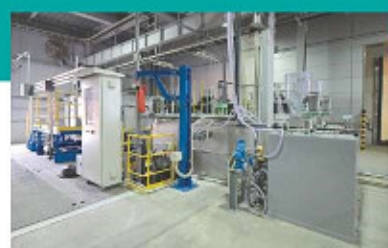
K 加圧浮上
